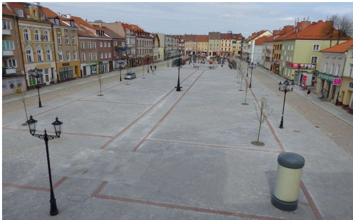
Rynek po modernizacji
